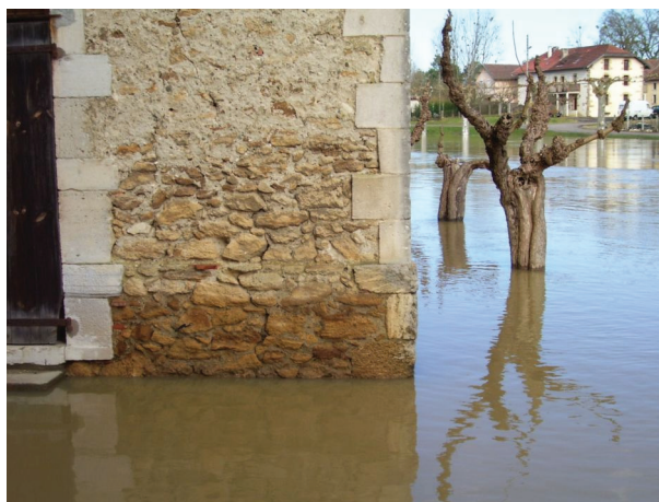
Illustration 4 : Trace d'humidité (La Midouze à Tartas, SCHAPI, 29/01/2009)
