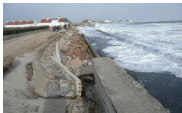
Illustration 8 : Dégradation d'un ouvrage de protection (Geos, Tempête du 10 et 11 mars 2008, Gâvres , 2008)
